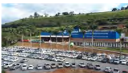
Centro de Distribuição
